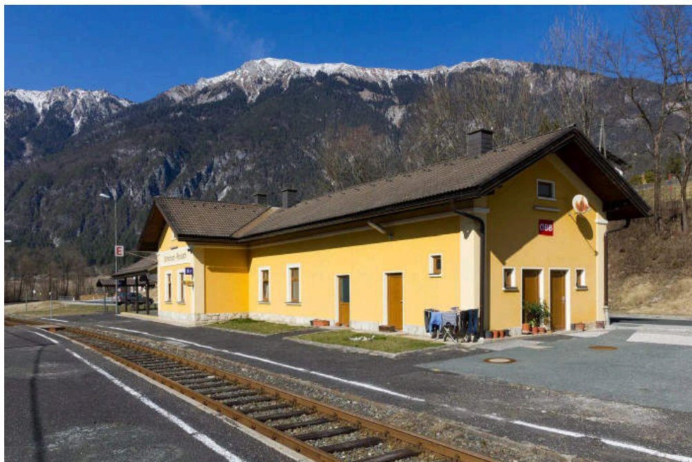
Abb. 27 · Das Stationsgebäude Görttschach-Förolach, 2017. Foto: Liberaler Humanist, CC BY-SA 3.0
